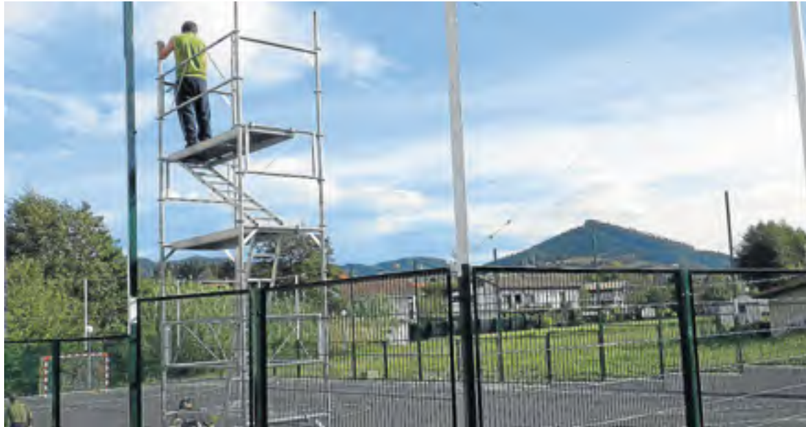
Las obras complementarias en el campo polivalente ya han comenzado. FOTO: LEZAMAKO UDALA
